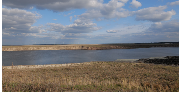
Aktuell ist die Flutung des zukünftigen Ostsees gestoppt um Reparaturen an der Kaimauer durchzuführen. Notwendig wurden diese nach Rutschungen.
