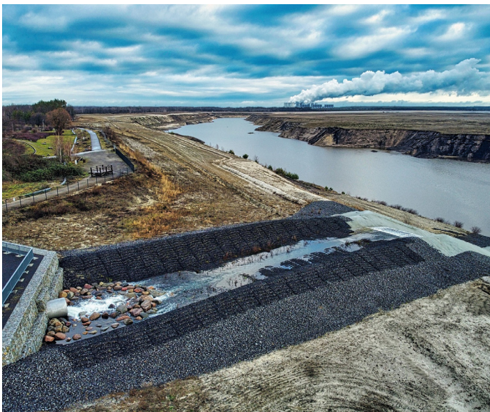
Lakoma: Von hier wird der Cottbuser Ostsee seit 2019 geflutet. Das ist jeweils abhängig von den verfügbaren Wassermengen und musste bereits wegen mehrerer Dürre-Zeiten gestoppt werden. Foto: Peter Rademacher/pixabay
